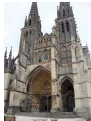
Façade occidentale, état actuel (Arch. dép. de l'Orne)
