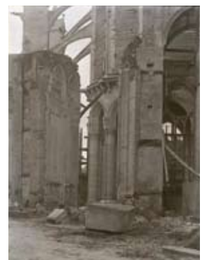
Le chœur de la cathédrale en travaux, vers 1890 (Arch. dép. de l'Orne)
