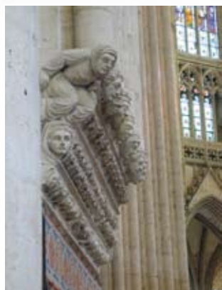
Culots de l'encorbellement de la pile nord-ouest de la croisée (Arch. dép. de l'Orne)
