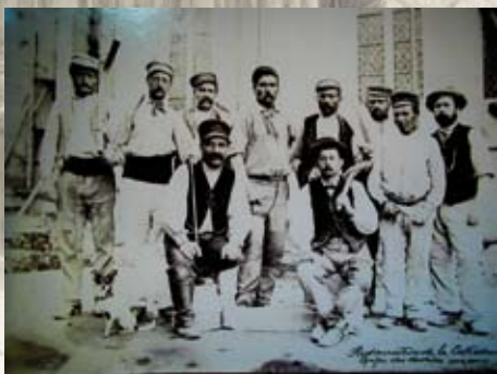
Restauration de la cathédrale. Les ouvriers maçons, vers 1895.
